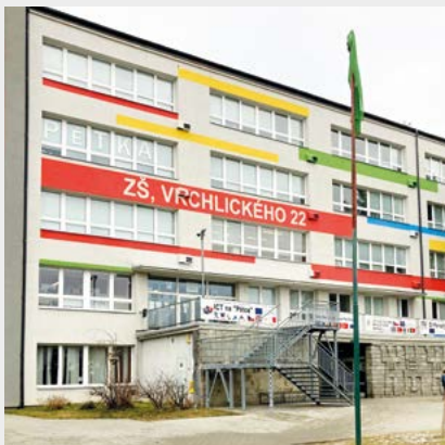
Jednou z největších investic je projekt Do odborných učeben bez bariér, který se realizuje na „Pěťce“. Foto: -pk-
